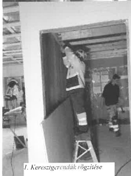
1. Az álmennyezet tartórészének rögzítése
