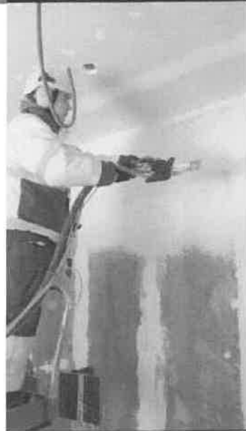
1. Gépi vakolat felhordása a felfelületre
